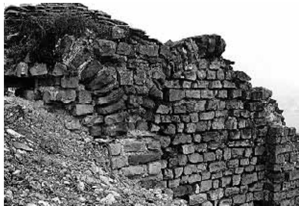
Abb. 2 a-b Igel, „Grutenhäuschen“, Zustand 1960.
