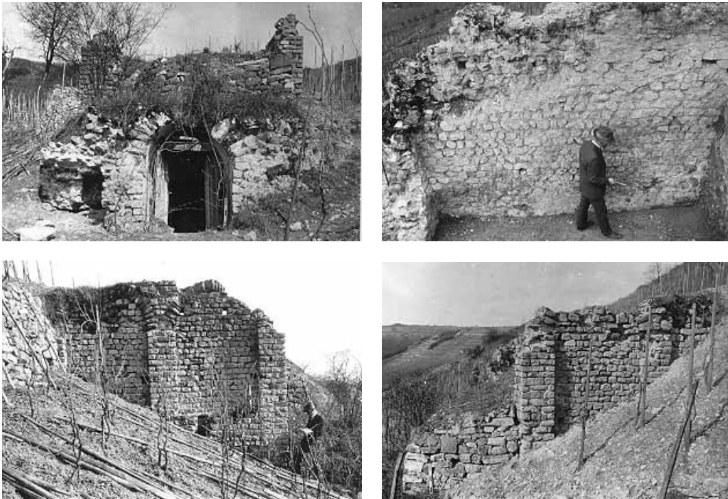
Abb. 1 a-d Igel, „Grutenhäuschen“, Zustand 1920.
